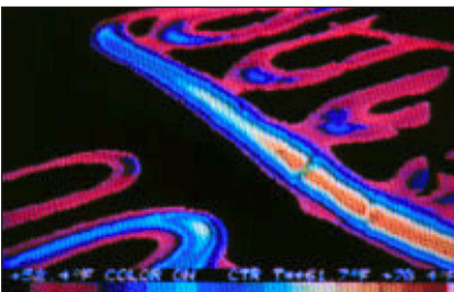
Figure 8: Thermogramme d'un serpentin de chauffage hydronique dans un plancher en béton.
