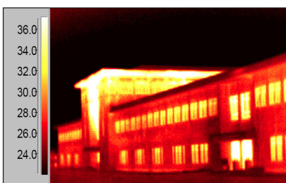
Figure 11: Lors de la mise en service du bâtiment, la thermographie a révélé un problème d'exfiltration sévère au travers le soffite. Gracieuseté Phil McMullen.
